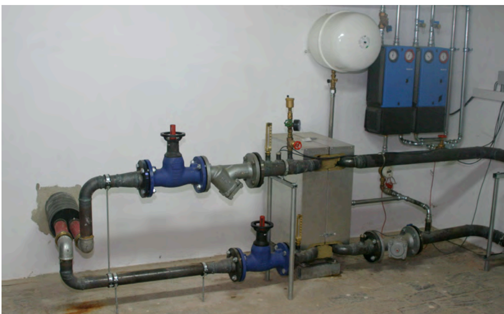
Das ist alles: In diesem silbernen Kasten (Mitte) treffen zwei Heizkreisläufe zusammen: Über einen Wärmetauscher wird die Wärme von der Biogasanlage (von links kommend) an die Heizung Marschke (rechts) abgegeben. Damit werden Gärtnerei und Wohnhaus beheizt und mit Warmwasser versorgt.
